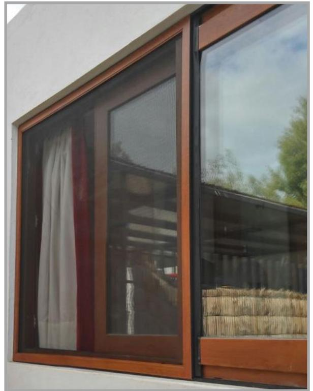
El Mosquitero Corredera, se desliza por una canal riel mediante la acción de rodamientos integrados en el perfil superior e inferior del mosquitero. Esto permite que el mosquitero pueda deslizarse hacia cualquiera de las hojas de la ventana que se requiera mantener abierta.
