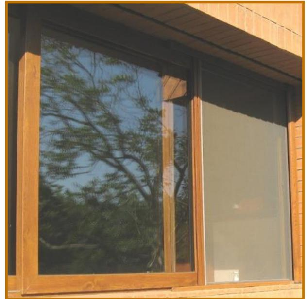
Mosquitero diseñado exclusivamente para ventanas corredera de 2 hojas móviles, en la cual el mosquitero queda instalado por fuera en la "hoja pasiva" de la ventana, permitiendo utilizar esta hoja para ventilación y la activa para el acceso libre.
